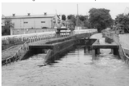
横手橋西の3ヶ村分水部。(中央が地下水の出口)
