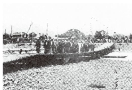
舟の上に板を張っただけの初代中橋 (ふるさとの思い出足利誌より)
